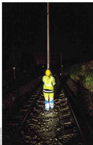
La "mise à la terre" est une opération délicate qui requiert de l'agilité. Munie d'une longue perche, Pearle tente d'attraper la câble en hauteur.
