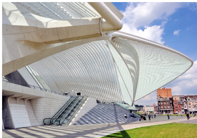
Entrée de l'actuelle gare de Liège-Guillemins (Ref. D3487-61)
