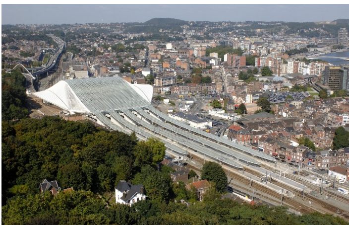
Photo aérienne de la quatrième gare de Liège-Guillemins (Réf. D3194-01)
