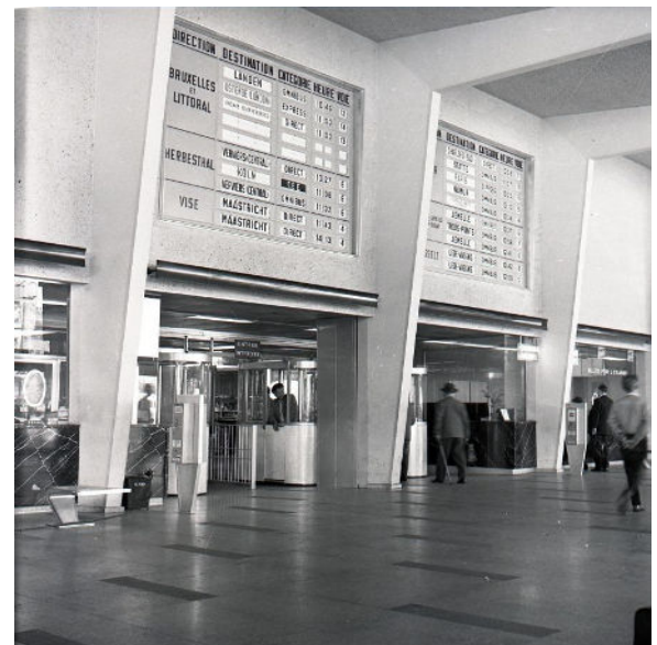
Annonceur de train automatique dans la salle des guichets de la troisième gare de Liège-Guillemins (Réf. Z03483B)
