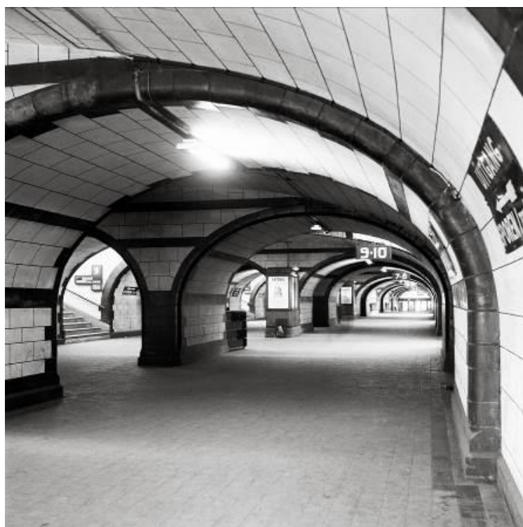
Couloir sous-voies de la deuxième gare (Réf. Z11080C)
