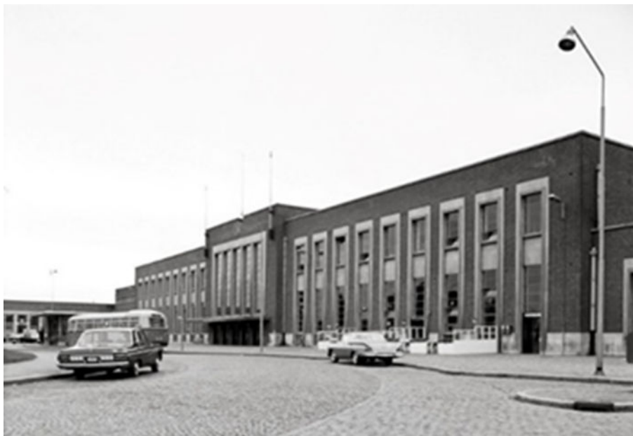
La troisième gare de Bruges (Réf. Z03813C)
